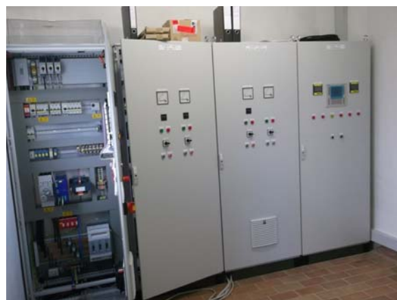
Austausch Schaltanlagen während des Betriebs
