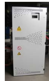
Zentralbatteriesystem
