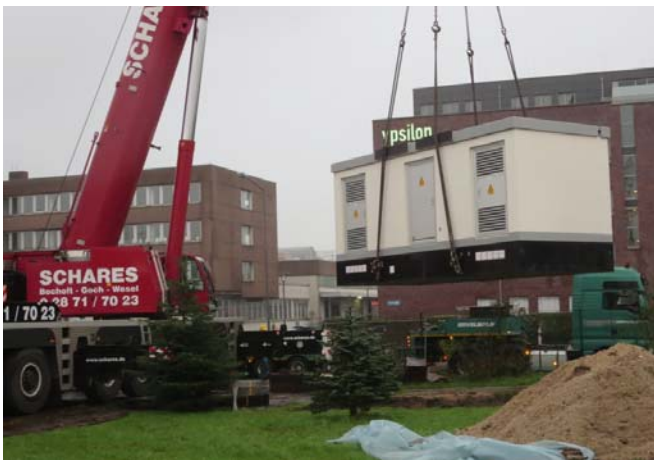
Anlieferung der Betonstation
