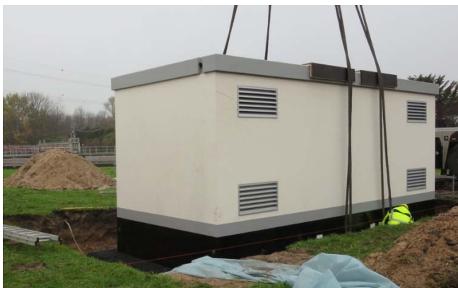
Aufstellung auf der Sauberkeitsschicht
