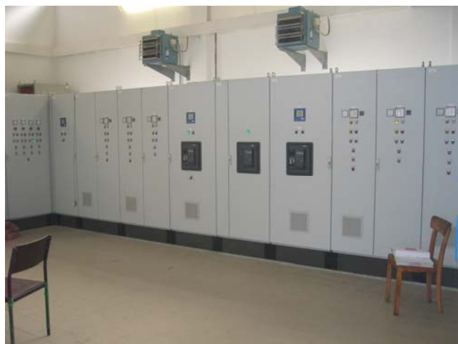
Neue NS-Schaltanlage
