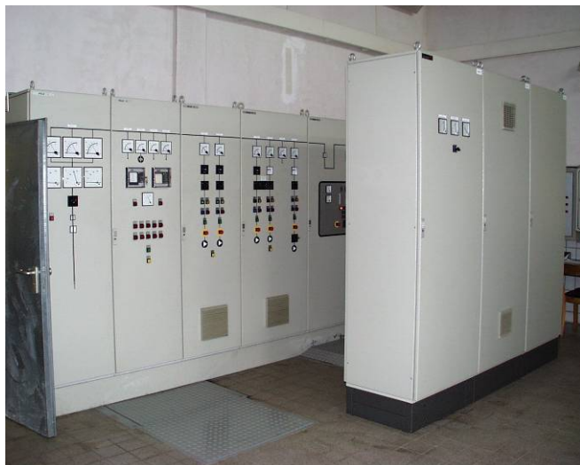
Alte NS-Schaltanlage
