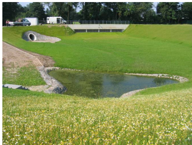
RRB als Erdbecken mit Notüberlaufbauwerk
