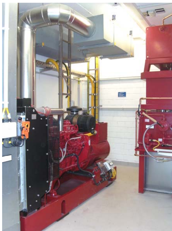
Netzersatzanlage
