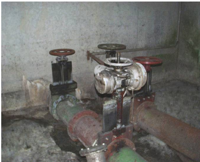
alte Absperr- und Drosseleinrichtungen vor dem Umbau
