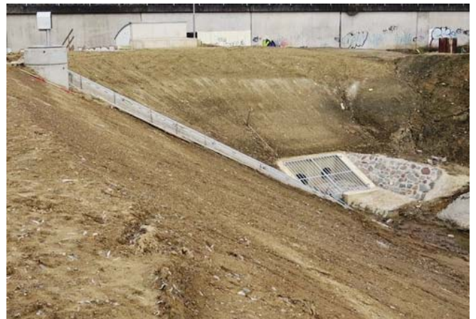
neues Auslaufbauwerk mit Pegelschacht
