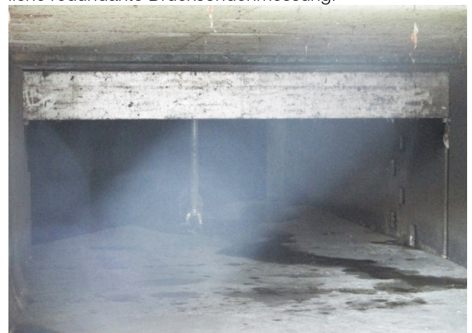
Bei andauerndem Regen erfolgt später ein Abschlag in das nachgeschaltete Regenrückhaltebecken.
