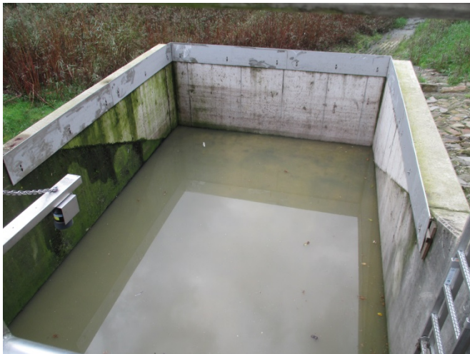
Bei andauerndem Regen erfolgt später ein Abschlag in das nachgeschaltete Regenrückhaltebecken.
