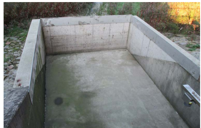
Bei fallendem Wasserstand wird die Sohle des Entlastungsbauwerks SK mit Hilfe eines Strahlreinigers bei niedrigen Wasserständen zunächst in intermittierendem und zuletzt im Dauerbetrieb gereinigt.
