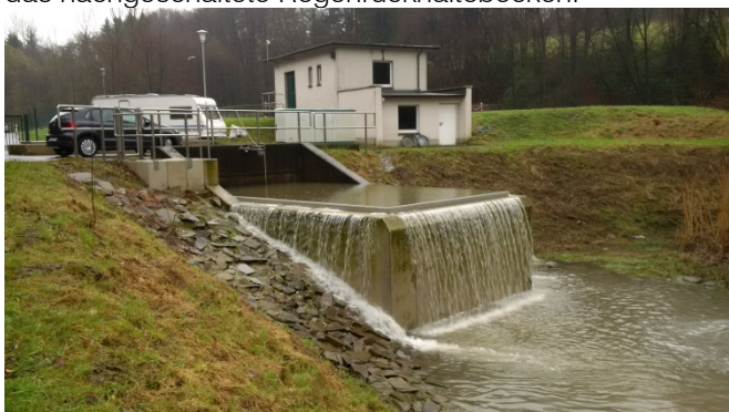
Bei fallendem Wasserstand wird die Sohle des Entlastungsbauwerks SK mit Hilfe eines Strahlreinigers bei niedrigen Wasserständen zunächst in intermittierendem und zuletzt im Dauerbetrieb gereinigt.
