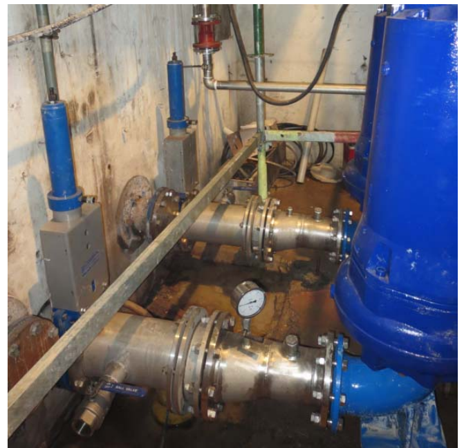
Umbau während des laufenden Betriebs
