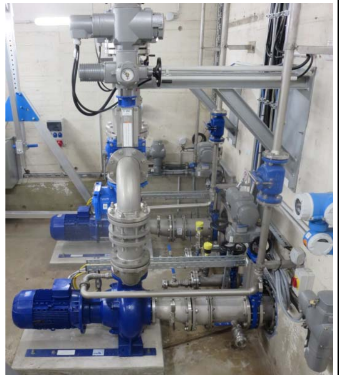
Umbau während des laufenden Betriebs
