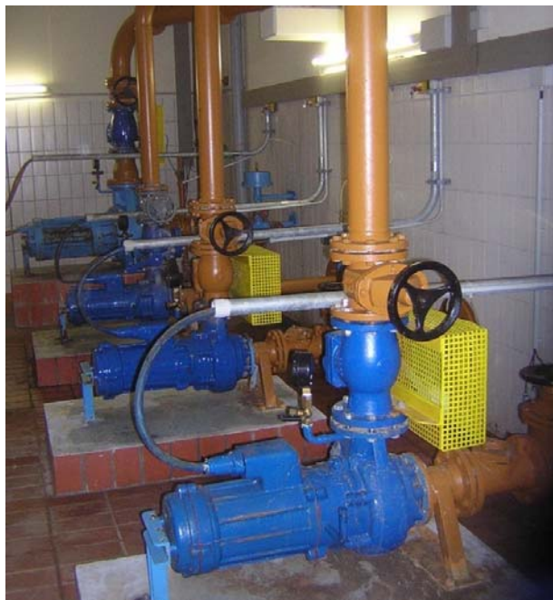
Alte Mischwasserpumpen
