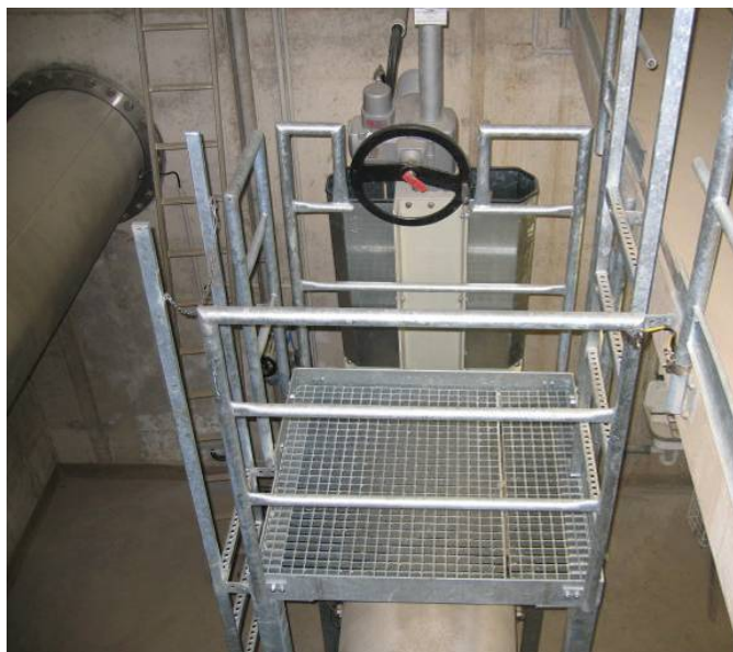
Bedienbühne Drosselschieber
