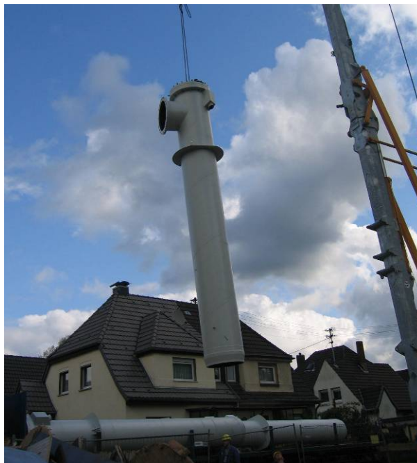
Einbringen Rohrschacht
