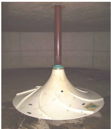
Vertikalrührwerk im RÜB
