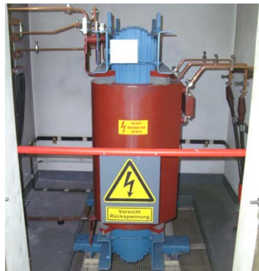
Gießharztransformator
