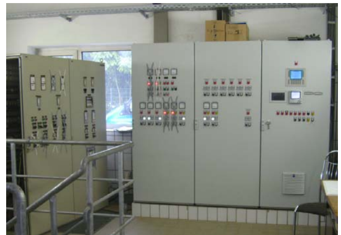
Austausch Schaltanlagen während des Betriebs
