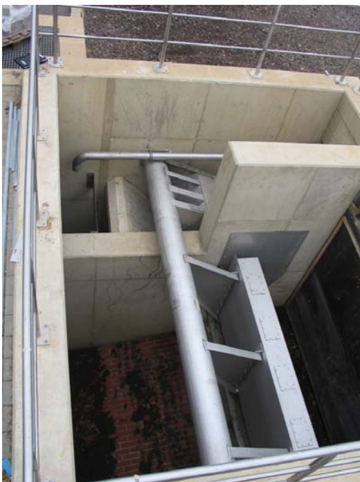
Schwimmergesteuertes Klappenwehr
