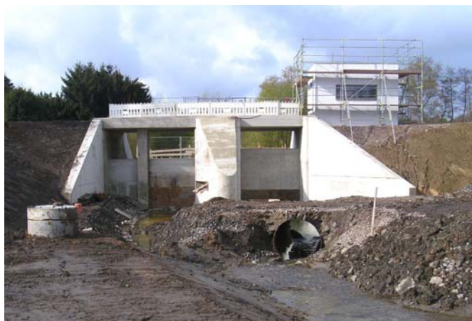
Drosselbauwerk während dem Umbau
