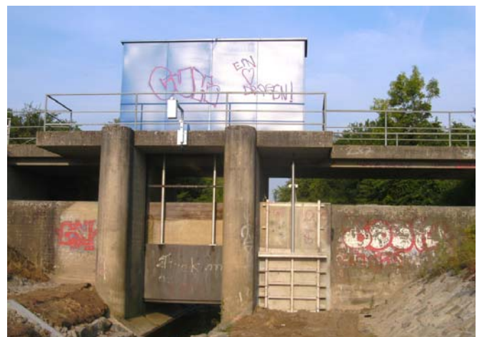
Drosselbauwerk nach dem Umbau
