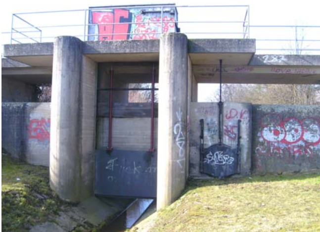
Drosselbauwerk vor dem Umbau
