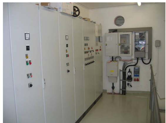
Neue Schaltanlage
