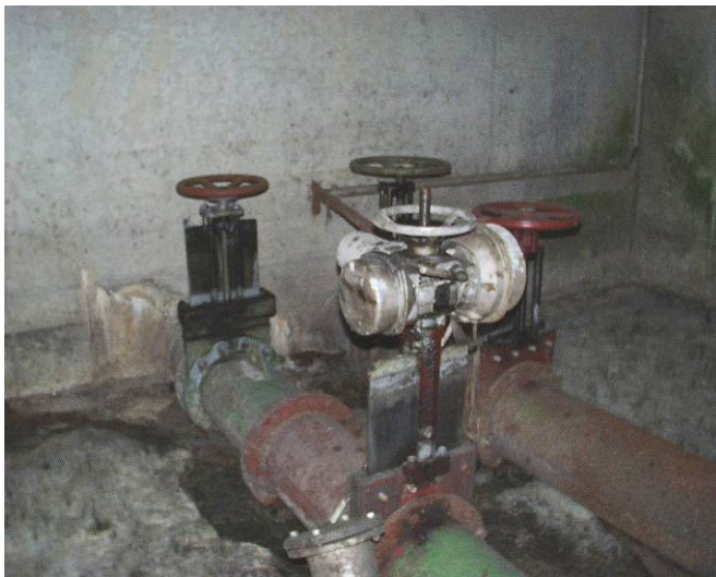
alte Absperr- und Drosseleinrichtungen vor dem Umbau
