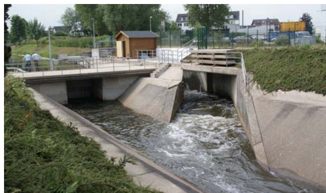
Wasserkraftanlage nach Inbetriebnahme
