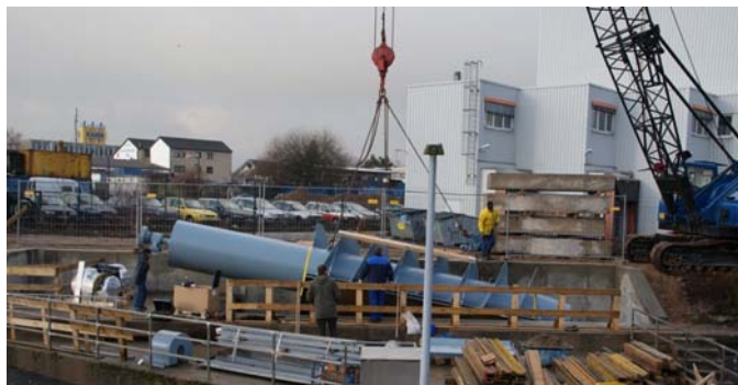
Montage der Kompaktschnecke mit Stahlblechtrug im Umgehungsgerinne
